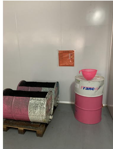
项目危废暂存间现状
